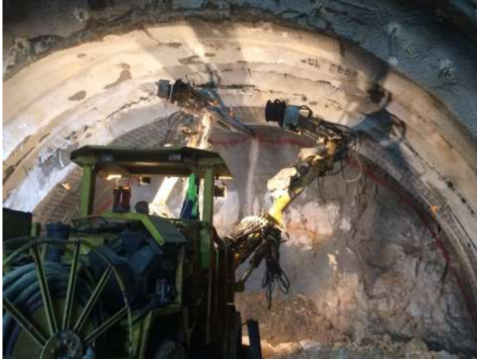
Şekil 3. Jumbo ile robbit delgisi
