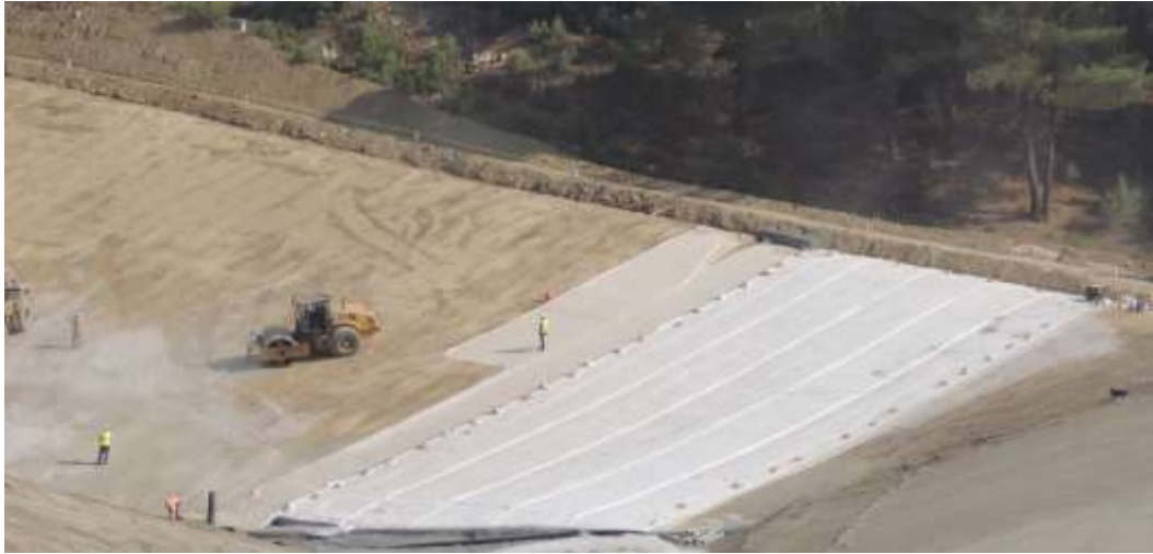
Şekil 3. Örnek Depolama Alanı İnşaatı JKA ve JDT Serimi
