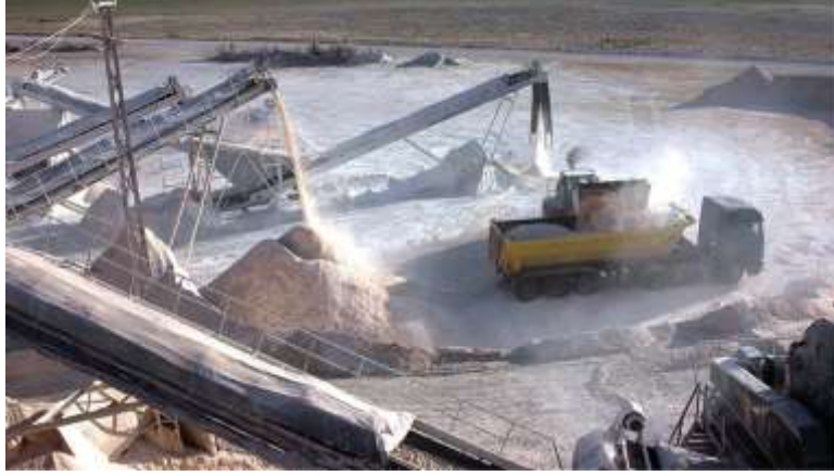
Şekil 2. Kırma Eleme tesisi tozlu çalışma
