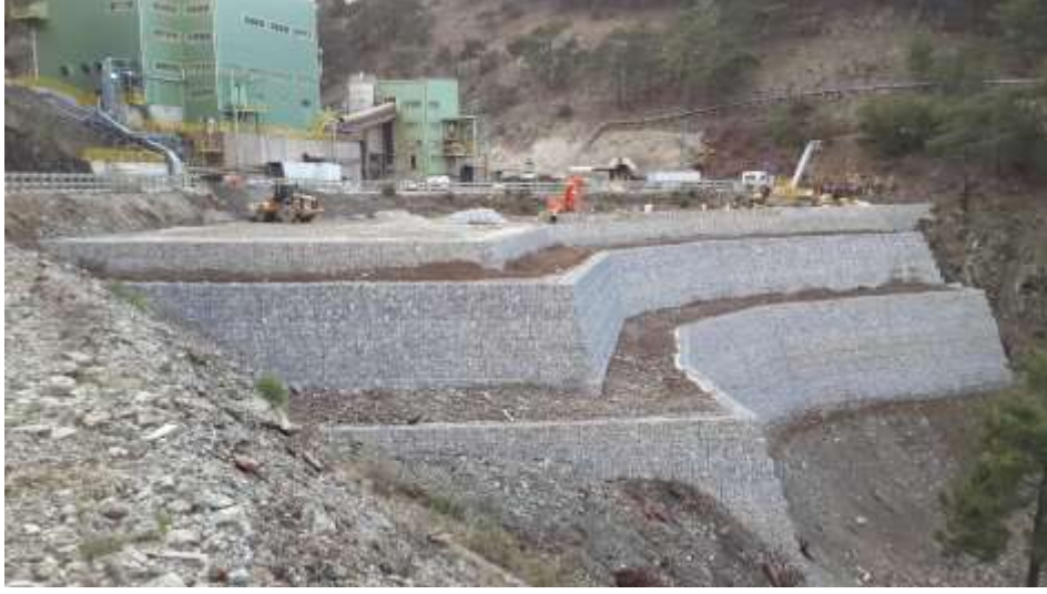
Şekil 11. Tesis alanı duvar imalatı (Maccaferri Türkiye– Tüprağ Efemçukuru Altın Madeni)
