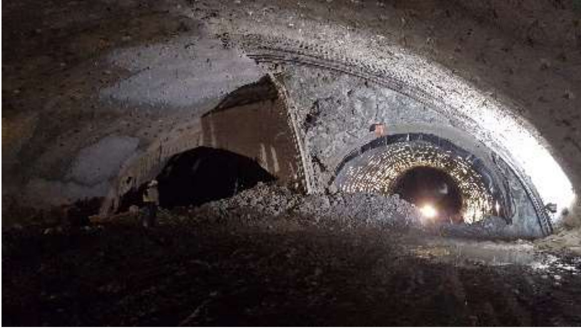
Şekil 11. Genişleme kesitinde üst yarı kazısının tamamlanmış durumu
