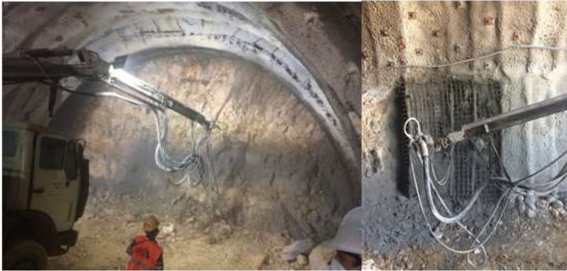
Şekil 4. İksa ve çelik hasır arasına shotcrete atılması
