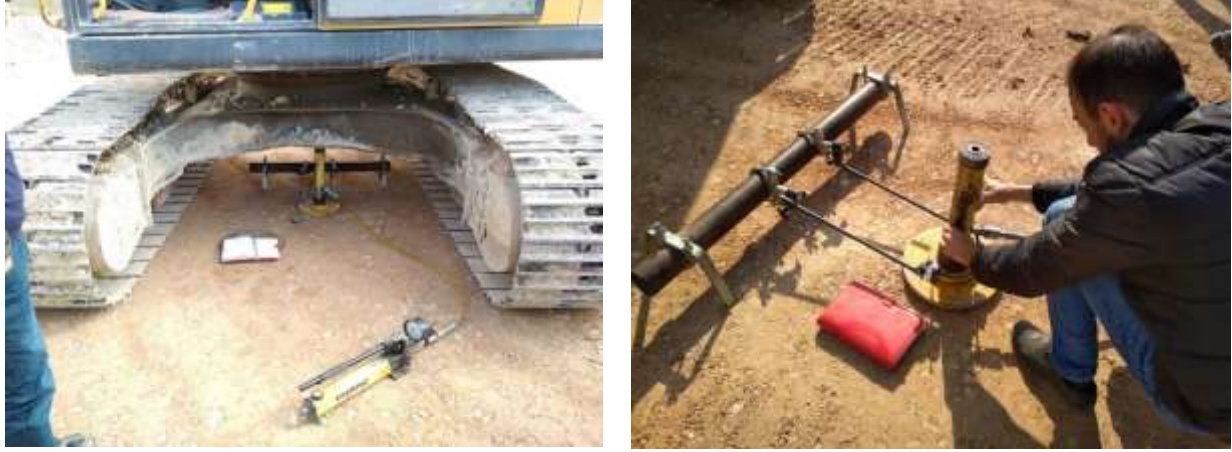
Şekil 10. Yapı temel kotunda ve plentmiks malzeme üzerinde gerçekleştirilen plaka yükleme deneyleri.
