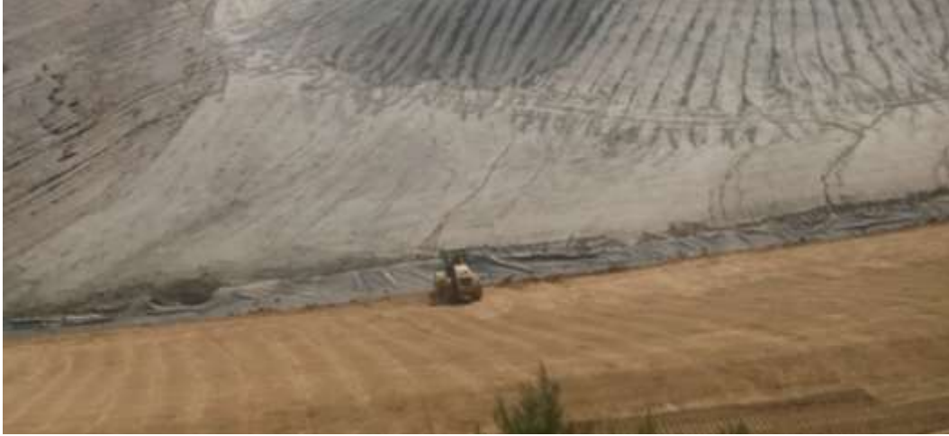
Şekil 2. Örnek Depolama Alanı İnşaatı Zemin Sıkıştırma
