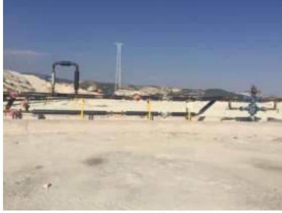
Şekil 5. Üretim Kuyusu Yer Üstü Teşkilatı
