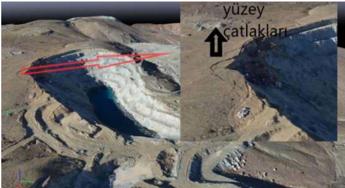
Şekil 8. Açık krom ocağında oluşan deformasyon çatlakları
