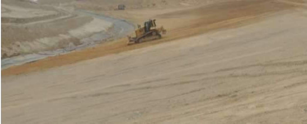
Şekil 1. Örnek Depolama Alanı İnşaatı Zemin Düzenleme
