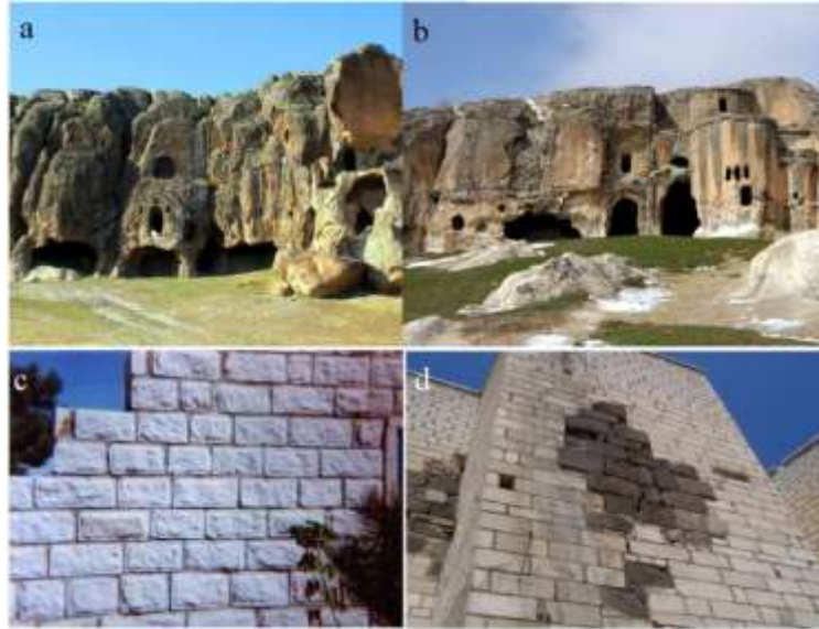
Şekil 1. Ayazini tüflerinde yapılan a) Ayazini kaya yerleşimleri, b) Ayazini Oyma kilise, c) güncel bir duvar, d) Afyon kalesi restorasyonu.
