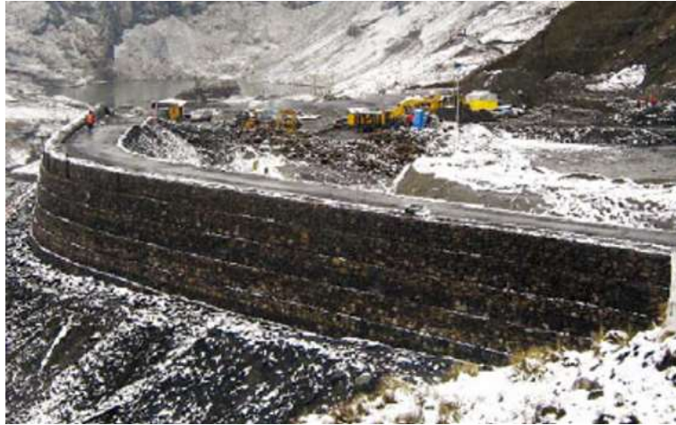
Şekil 6. Terramesh sistem ile yapılmış servis yolu (Mina Yauricocha, İtalya)
