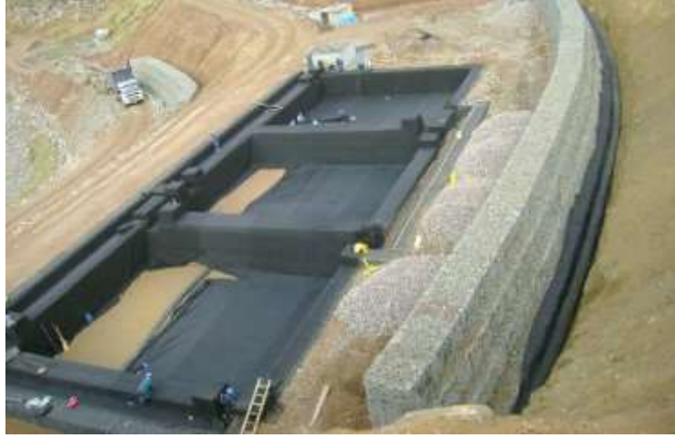
Şekil 7. Depolama sahası şev topuk yapısı (Officine Maccaferri Mina Goldex Peru)
