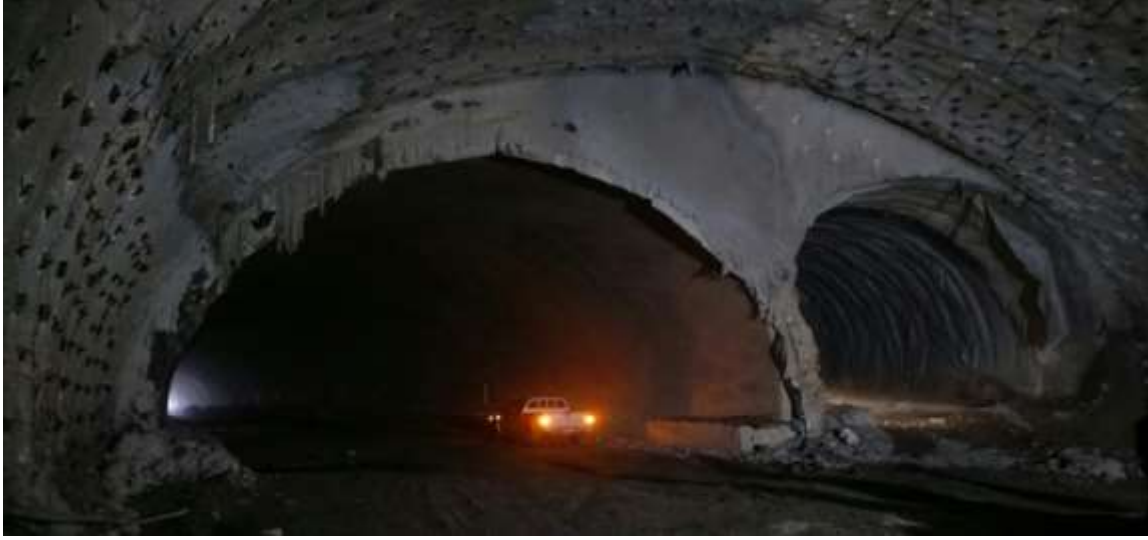
Şekil 12. Genişleme kesitinde kazının tamamlanmış hali
