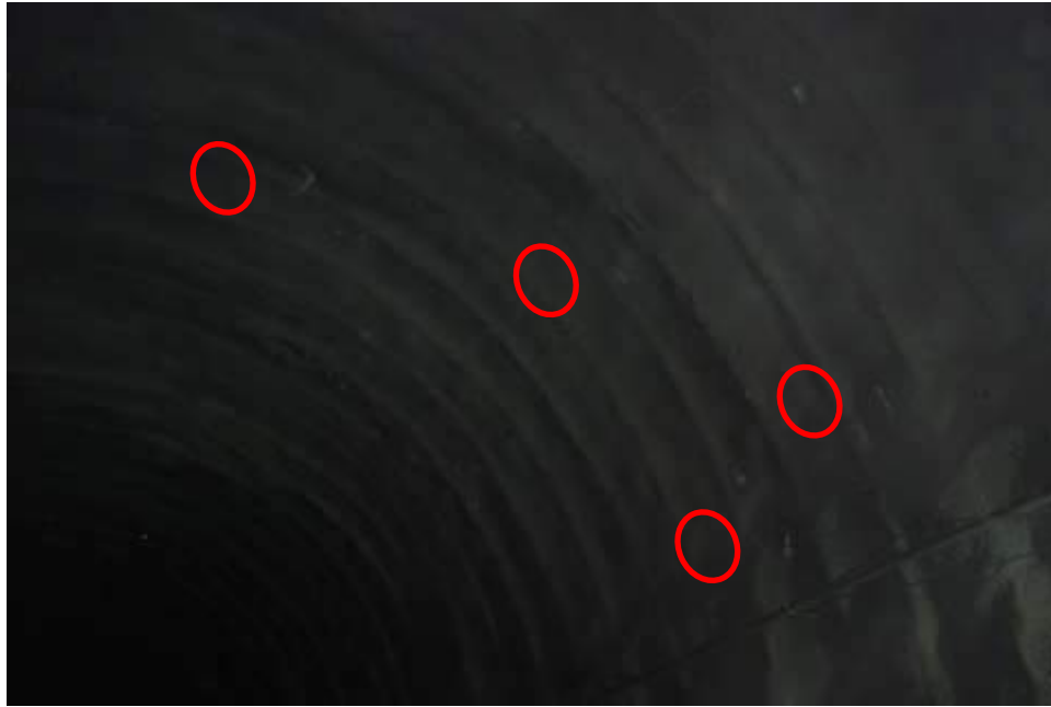
Şekil 7. Tünel omuzlarında püskürtme beton kaplamasında meydana gelen çatlaklar
