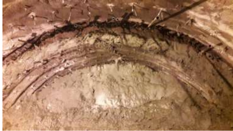
Şekil 12. Göçük sonrası kazı ve tahkimat işleri
