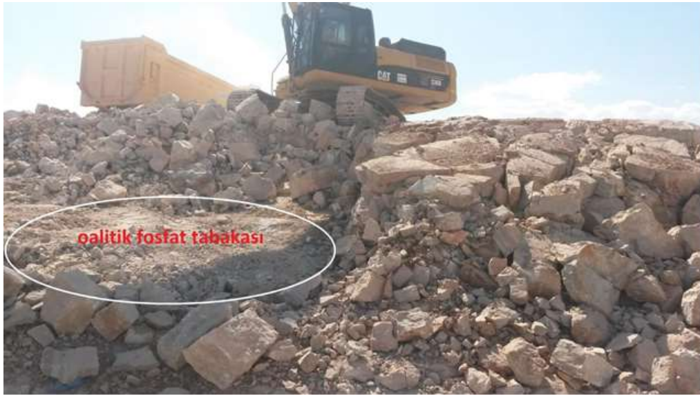
Şekil 9. Patlatma sonucu cevher paşa ayırımı
