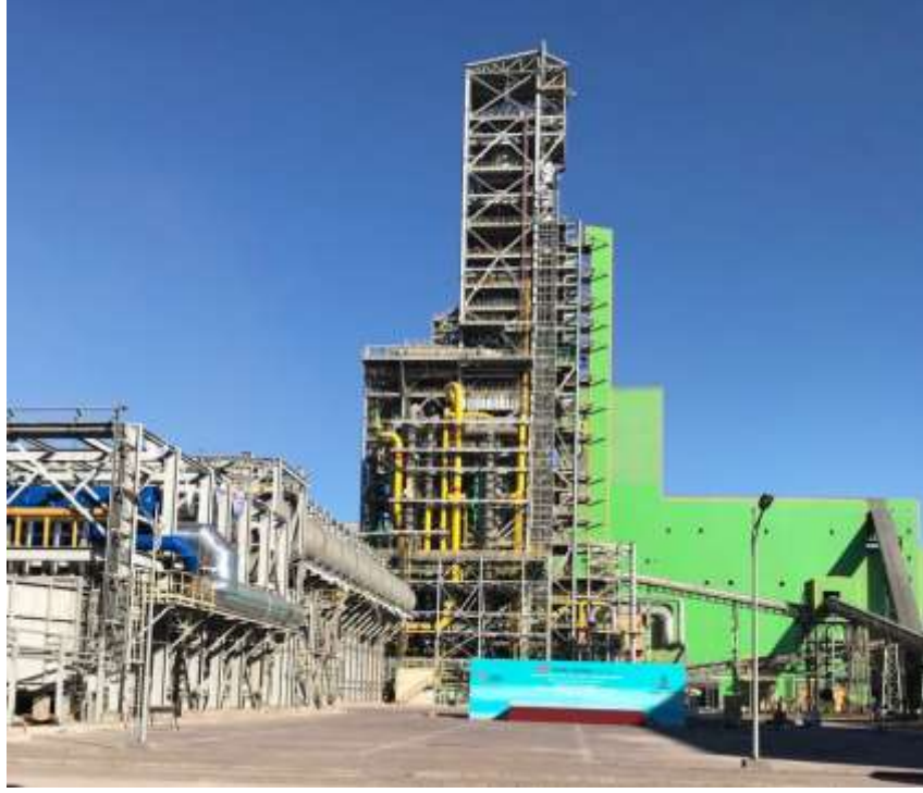
Şekil 1. Tosyalı Holding Cezayir 2.5 mton/yıl kapasiteli Midrex DRI tesisi
