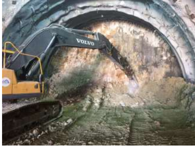
Şekil 2. Tünelde hidrolik kırıcı ile kazı işlemi
