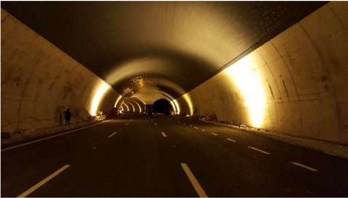
Şekil 13. Genişleme kesitinde tünel kaplamasının tamamlanmış durumu
