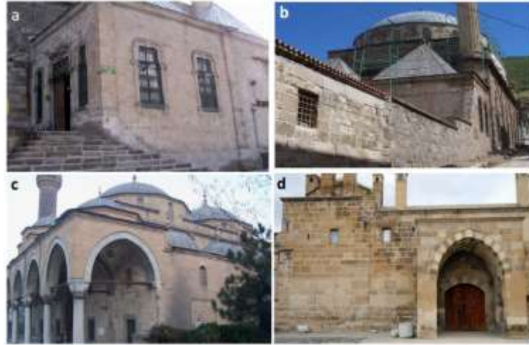
Şekil 1. Afyonkarahisar yöresinde Döğer tüflerinin kullanıldığı tarihi yapılar a-b) Mevlavi Türbe Cami (1905), c) İmaret Cami (1472), d) Döğer kervansarayı (1434).
