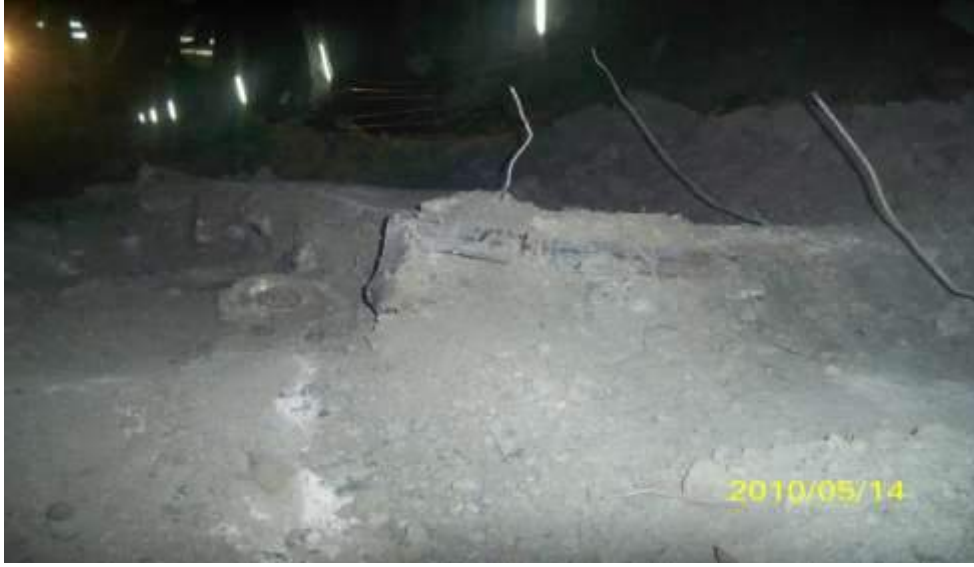
Şekil 8. İnvvertlerde meydana gelen kabarmalar
