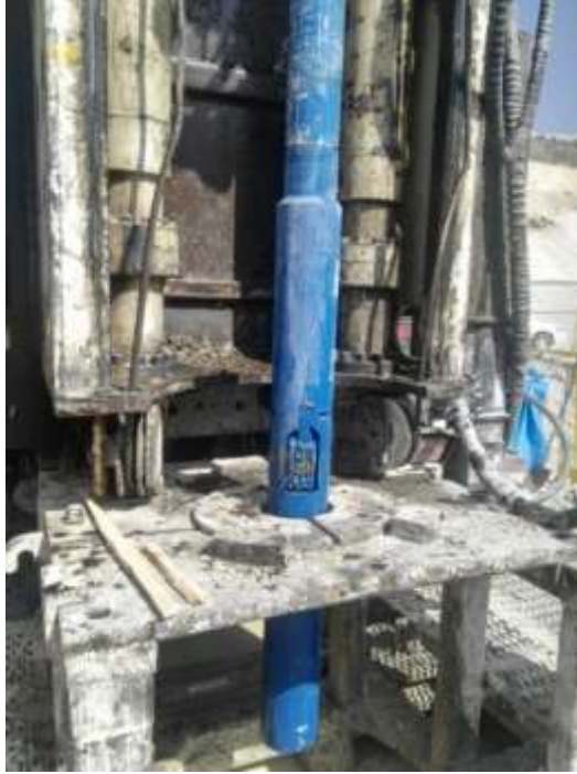
Şekil 10. Operasyon Öncesi Öğütücü Aparatın Kuyuya İndirilmesi
