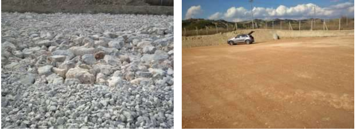
Şekil 9. Blokaj malzeme üst kademesinde yer alan kireçtaşı balast malzemesi (solda) ve en üstte kazı taban kotunu oluşturacak şekilde sıkıştırılarak serilen plentmiks dolgu malzemesinin görünümü (sağda).
