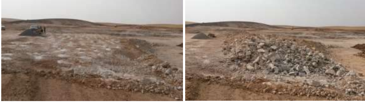
Şekil 12. Patlatma öncesi ve sonrası fotoğraf
