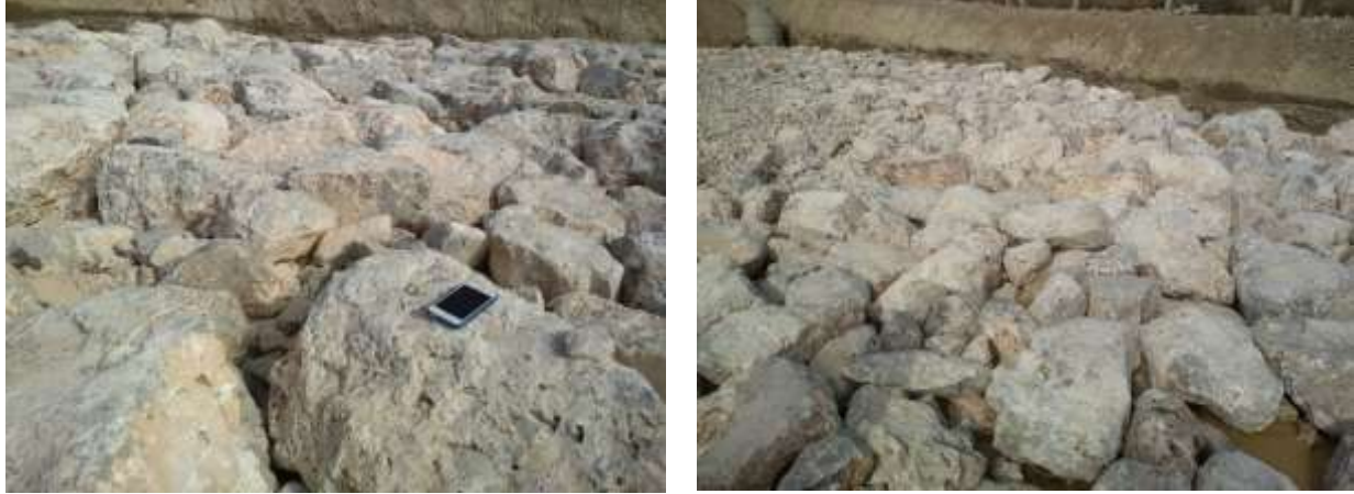
Şekil 7. Kazı çukuru tabanında sıkıştırılarak serilen kireçtaşı blokaj malzemenin görünümü.
