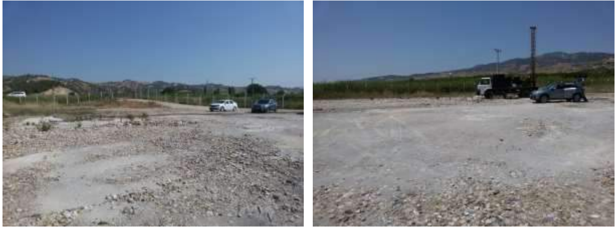
Şekil 1. İnceleme alanının genel görünümü ve etüt aşamasında yapılan sondaj çalışmaları.
